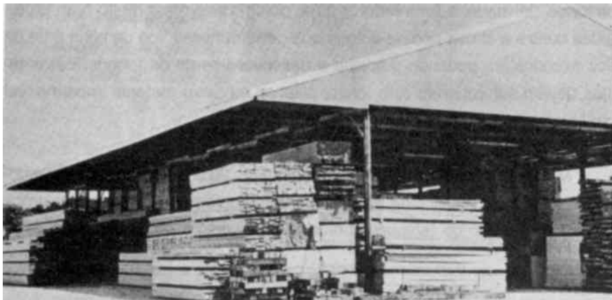
Figura 17 — Galpão aberto, para armazenamento de madeira serrada, Rietz & Page, 1971 (12).
