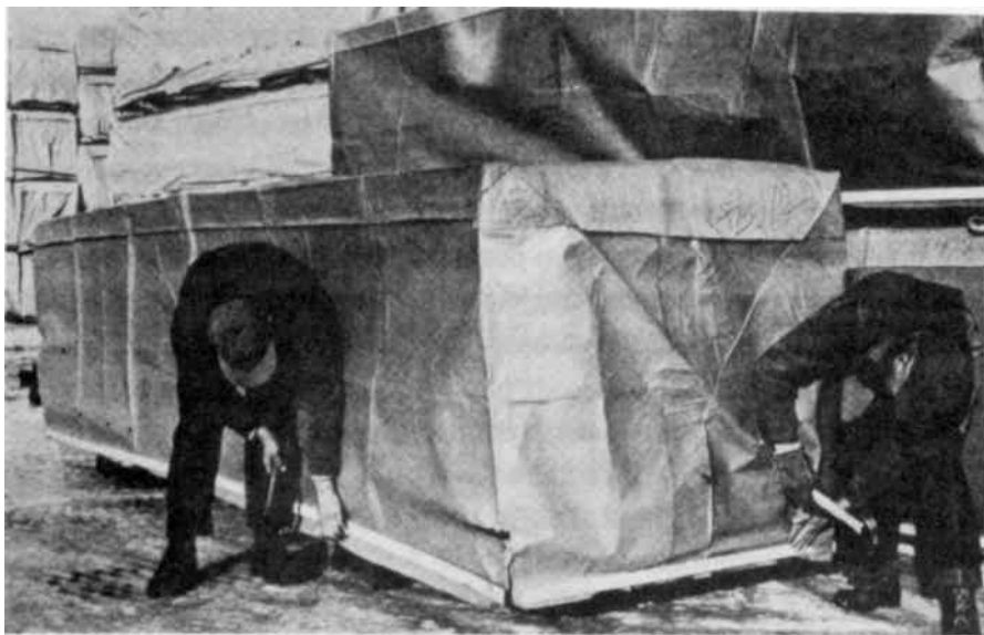
Figura 16 - Proteção temporária para estocagem ao ar livre, Rietz & Page, 1971 (12).
